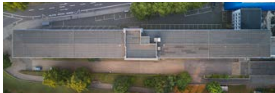
Ein gigantisches Bauwerk, dessen Abriss große Mengen an Abfall und Emissionen erzeugen würden
