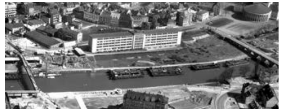
Das ehemalige Finanzamt liegt in bester Lage direkt am Ufer der Saar
